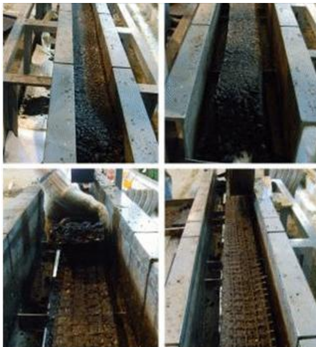
Рис. В.6.2. Процесс извлечения геосетки из конструкции
